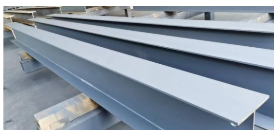
图 5.7.5 水性无机防腐涂料施工
