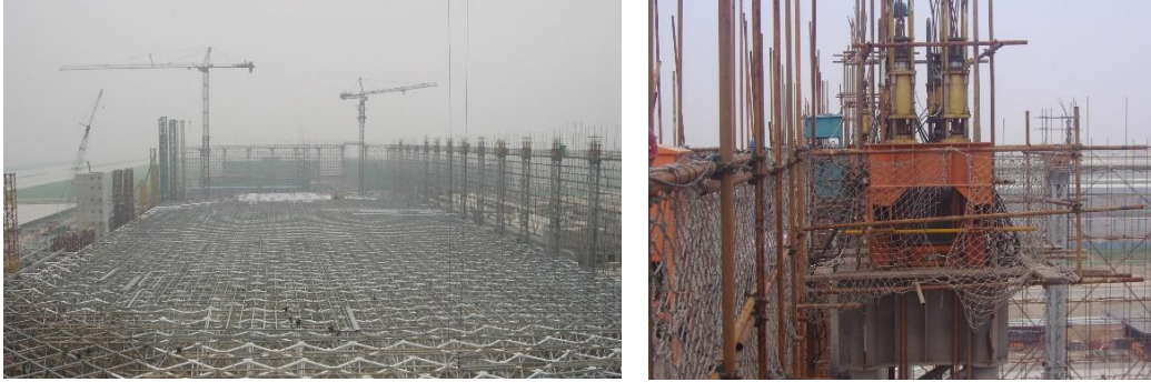
图 5.8.3 液压提升技术应用
