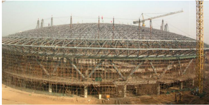
图 5.8.4 钢网架整体顶升技术应用
