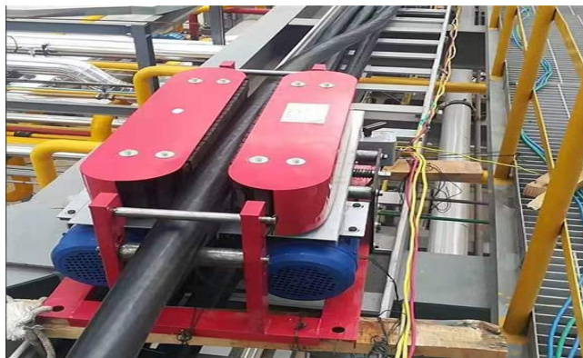
图 6.9.1 履带式电缆输送机应用
