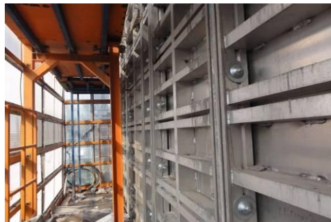
图 3.4.2 爬模模板及架体
