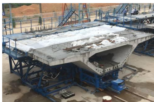
图 3.9.2 短线预制节段箱梁模板
