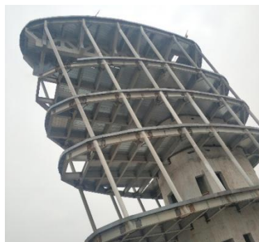
图 5.2.2 施工完成效果
