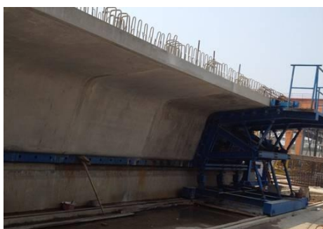
图 3.9.1 长线预制节段箱梁模板
