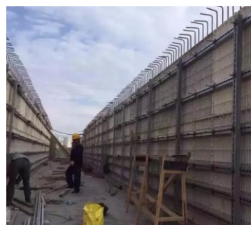
(2) 混凝土分三次浇筑的模板
