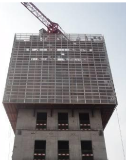
图 3.4.1 液压爬升模板外立面图
