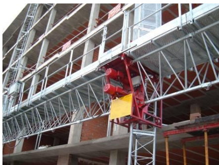
图 3.3.1 电动桥式脚手架
