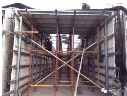
(1) 混凝土分两次浇筑的模板
